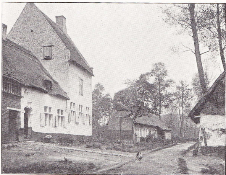
ASSCHE — Vieille habitation à toits de chaume, à Asbeek
